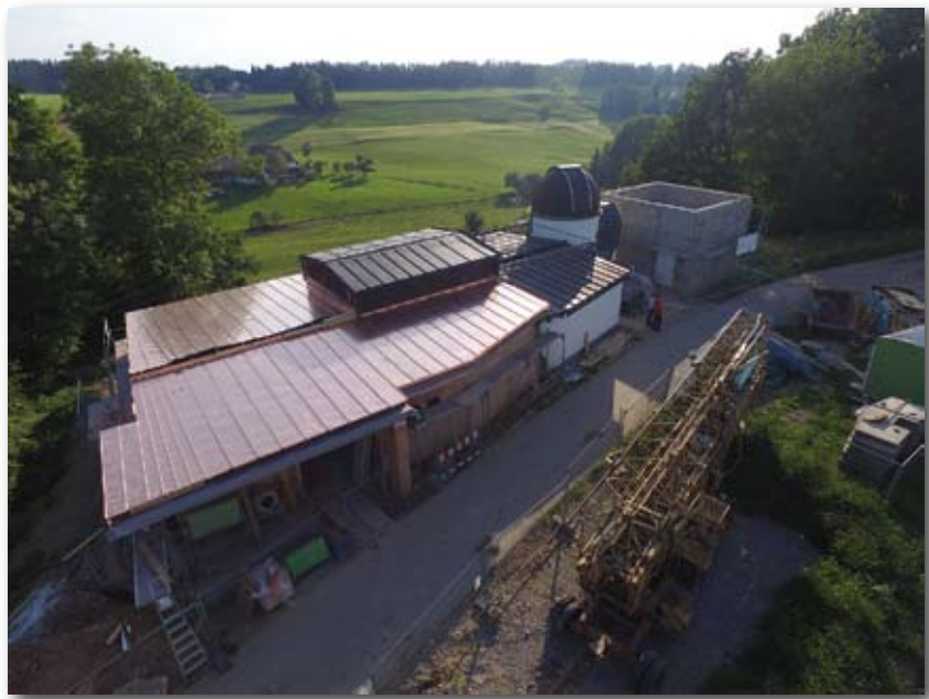
Baufortschritt am 20.06.2017 - Drohnenaufnahme von Manuel Fernbacher
