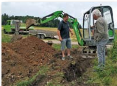
Mit einer Sondierungsgrabung wurde die Tiefe des Felssockels festgestellt.
