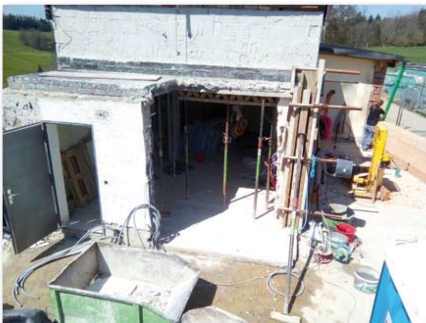
Erweiterungsbau der Sternwarte am 24.04.2017: Die bisherige Toilette ist abgerissen, die Wand zum Aufenthaltsraum fehlt. Baustelle pur...!
