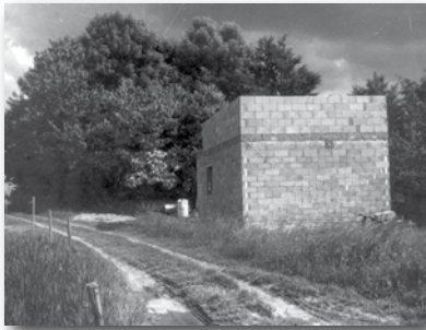
Rohbau der Sternwarte 1968
